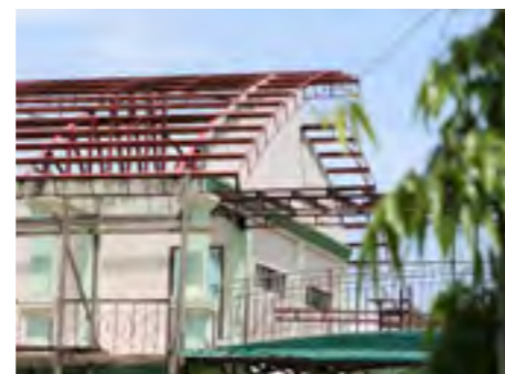
Rohbauphase des Holy Infant College Tacloban.
